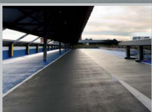
Bodenbeschichtung OS 10, hohe Rissüberbrückung
