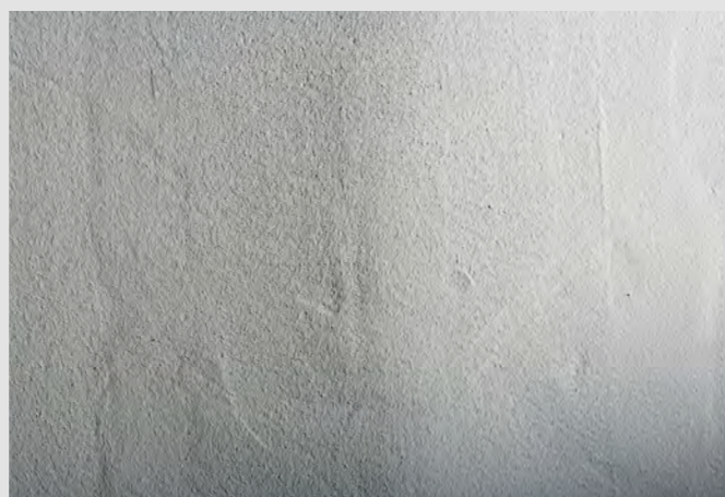
Erhöht gespachtelte Fuge bei viel Streiflicht
