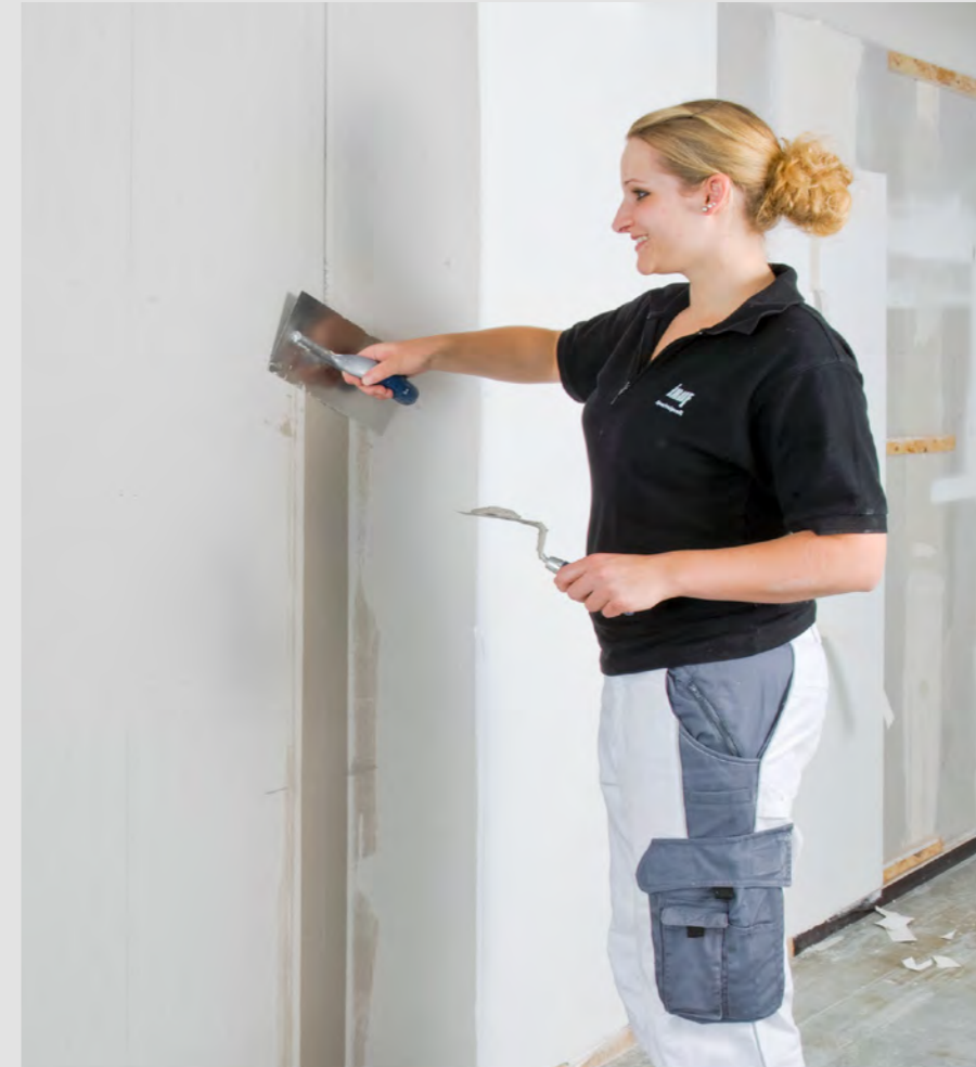
Risse sicher spachteln mit Knauf Spachtelmasse
