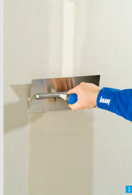
Überspachteln des Fugendeckstreifens mit gebogener Traufel
