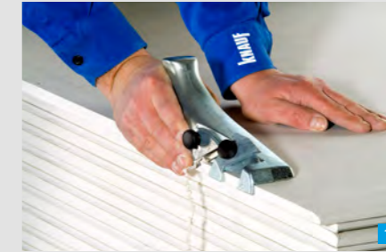
Anfasen einer SFK mit dem Kantenhobel
