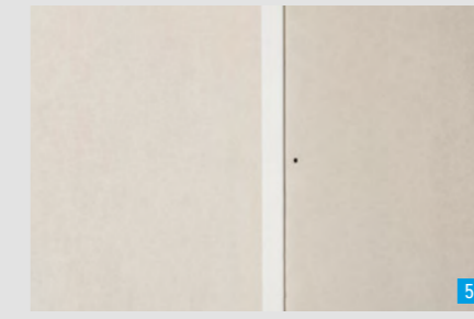
5 Gipsplatten mit ca. 5 mm Abstand montieren
