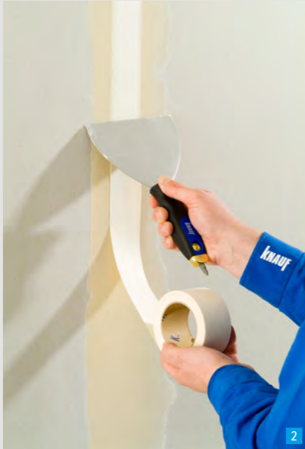
Einlegen des Fugendeckstreifens
