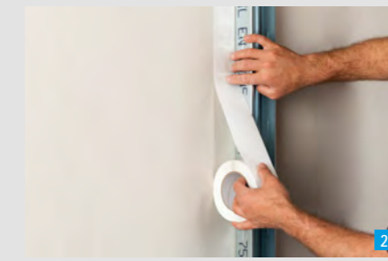
2 Trenn-Fix neben Profil kleben
