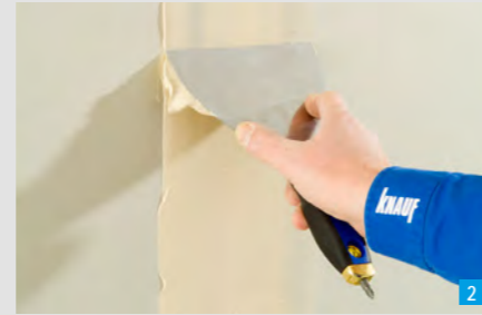
Abziehen in Längsrichtung
