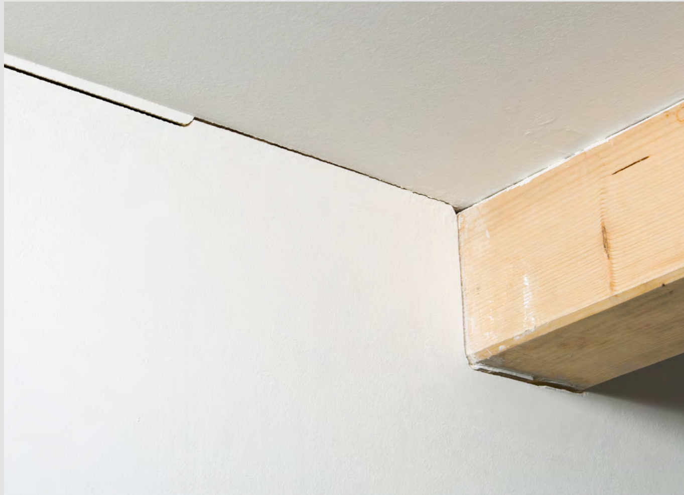
Überspringender Riss aufgrund fehlender Bauteiltrennung
