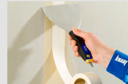
Einlegen des Fugendeckstreifens
