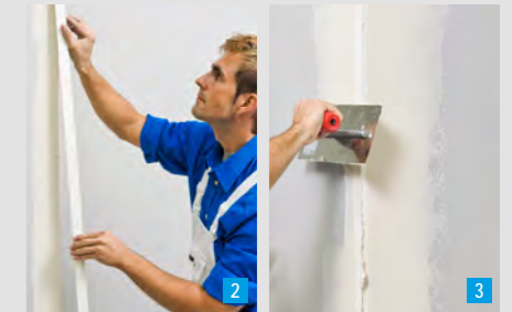
... und einlegen, anschließend überspachteln
