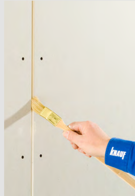
Aufbringen von Knauf Tiefengrund
