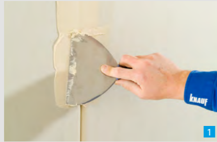
Eindrücken der Spachtelmasse quer zur Fuge
