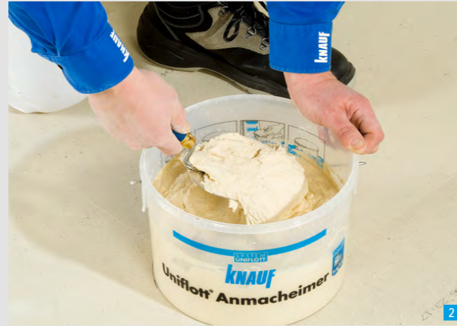
Anrühren von Knauf Uniflott mit der Kelle
