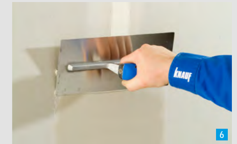
Überspachteln des Fugendeckstreifens
