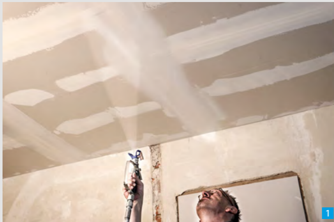
Knauf Fill & Finish lässt sich auch mit Airlessgeräten verarbeiten. Dazu wird dem 20-kg-Gebinde jeweils ein Liter Wasser hinzugefügt.
