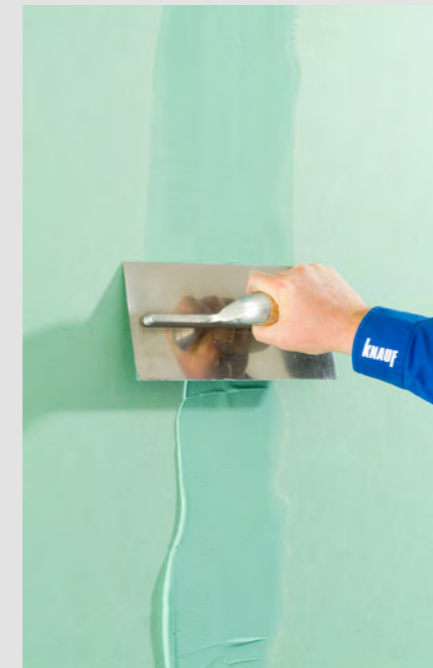
Knauf Uniflott imprägniert für imprägnierte (grüne) Gipsplatten
