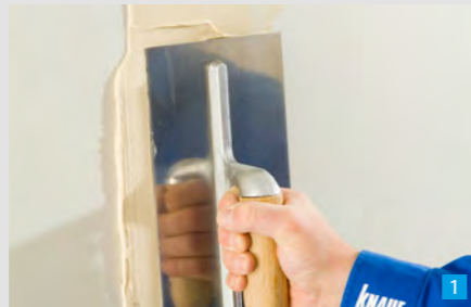
Eindrücken der Spachtelmasse quer zur Fuge
