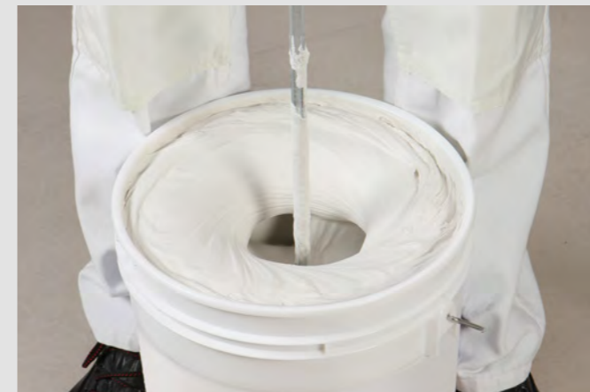
Auführen von Knauf Superfinish mit dem Quirl.
