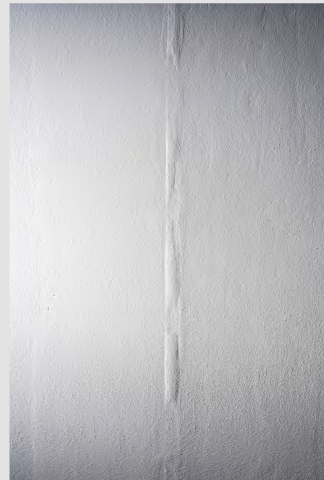
Halbseitiges und teilweises Ablösen des Fugendeckstreifens nach dem Anstrich
