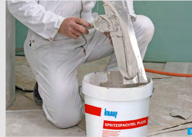
Knauf Spritzspachtel plus direkt aus dem Eimer entnehmen
