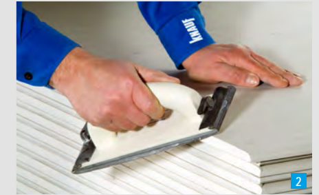
Brechen mit dem Handschleifer bei Knauf Cleaneo-Platten
