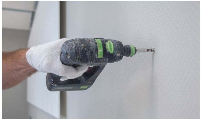
Bild 7: Festschrauben des Magnetsockels
