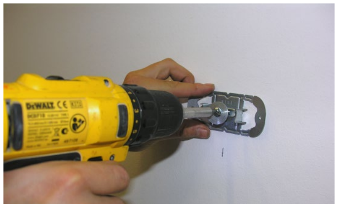
Bild 13: Anbringen des Direktmontage-Clips
