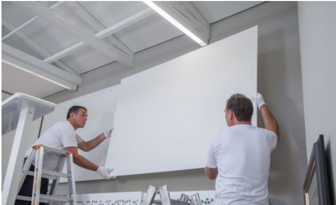
Bild 9: Positionierung des Cleaneo Single Smart Wandabsorbers
