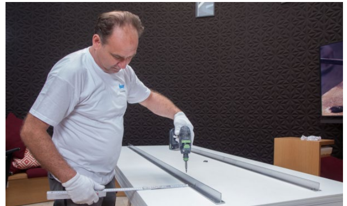
Bild 18: Montieren der rückseitigen Aussteifung
