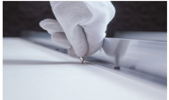
Bild 19: Einschrauben der Hängerunterteile
