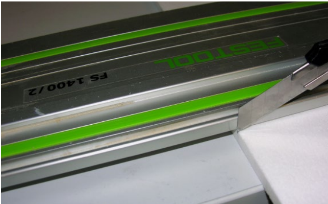
Bild 15: Zuschneiden des Cleaneo Single Smart
