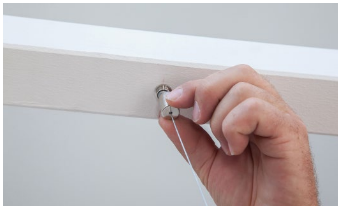
Bild 21: Festschrauben des Hängeroberteils
