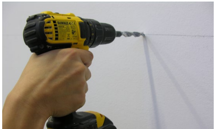
Bild 12: Bohren der Löcher für Befestigungsmittel
