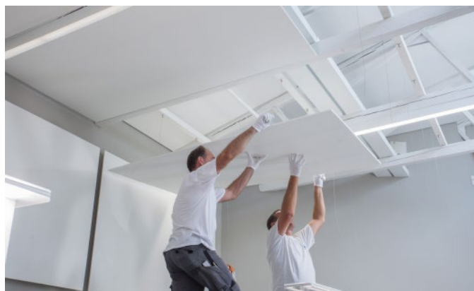
Bild 23: Ausrichten des Cleaneo Single Smart Deckensegels
