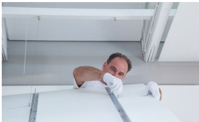
Bild 22: Einfädeln des Seils
