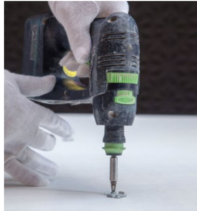
Bild 6: Befestigen der Blechhalterung
