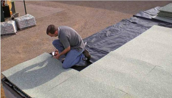
1. Auslegung der MOGAT Trenn- und Gleitfolie (mit 15 cm Überlappung) auf die wurzelfeste Dachabdichtung.
