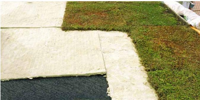
3. Jetzt folgt die Vegetationsschicht: Die Sedummaten werden sehr dicht gestoßen möglichst versetzt verlegt. Dabei darf kein Zug ausgeübt werden, durch den die Matten gestreckt würden. Nach dem Verlegen werden die Sedummaten durchdringend gewässert. Achten Sie darauf, dass auch die unteren Schichten bis zur Sättigung beregnet werden; dies gilt insbesondere auch bei anfänglichen und/oder längeren Trockenperioden im Anschluss an die Verlegung.
