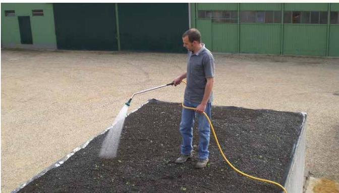
6. Durchdringende Wässerung der Dachbegrünung – am besten so viel, bis das Wasser abfließt. Je nach Witterung ist insbesondere in der Anwuchsphase darauf zu achten, dass die Dachbegrünung regelmäßig mit Wasser versorgt wird.
