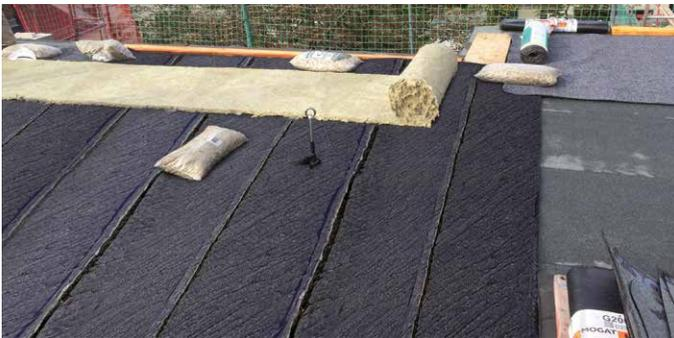
2. Auf die Drain- und Filtermatte verlegen Sie die Wasserspeichermatte lagenversetzt, quer zur Laufrichtung der Drain- und Filtermatte, und ohne Überlappung. Auf die Wasserspeichermatte streuen Sie anschließend den organischen Fertigdünger (Aufwandsmenge ca. 80 g/m<sup>2</sup>).
